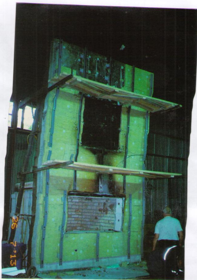
Рис.5.22. Общий вид после испытания «подконструкций» и минераловатных плит утеплителя образца фасадной системы «Альт-Фасад-06». [См. совместно с рис. 5.23...5.25].
