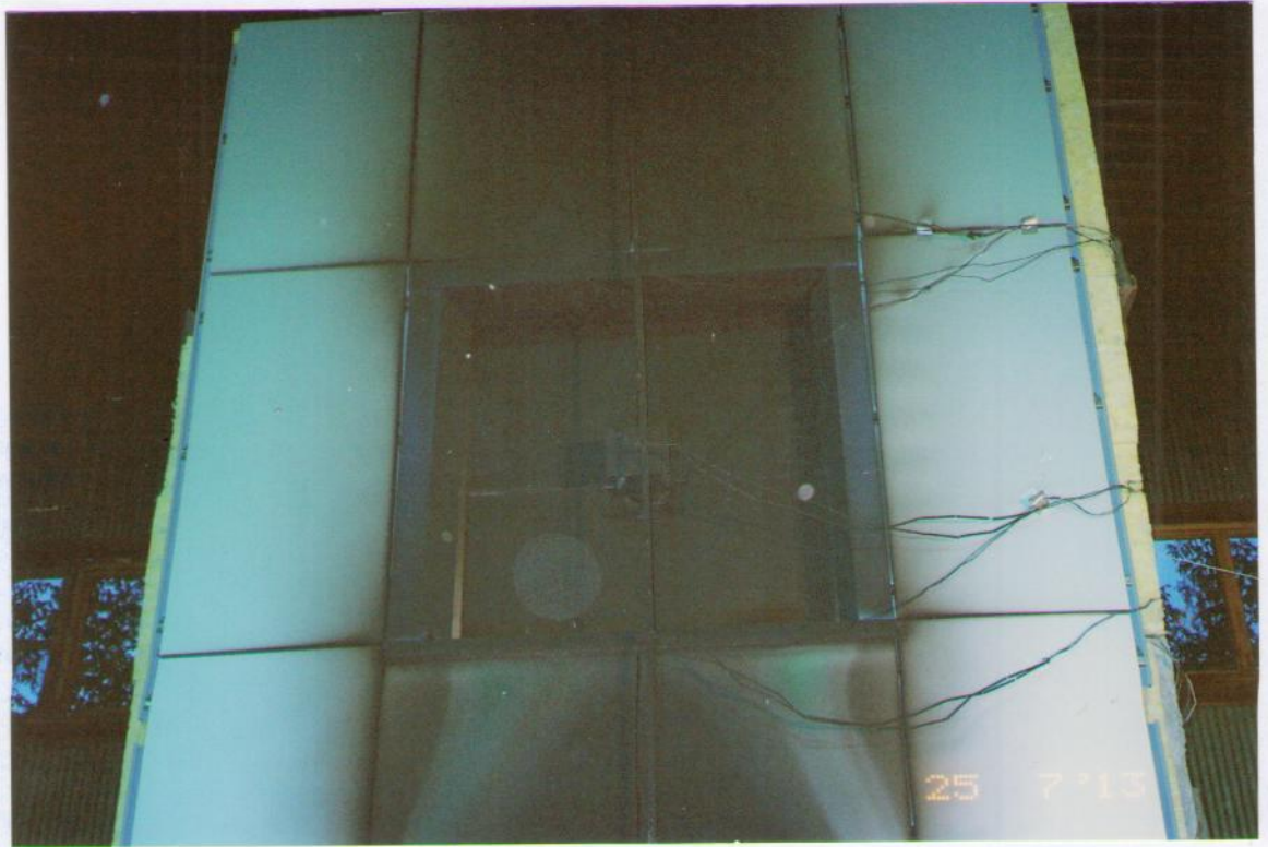
Рис.5.11. Общий вид после испытаний участка образца фасадной системы «Альт-Фасад-06» между нижним откосом имитации оконного проема и верхним торцом образца.
