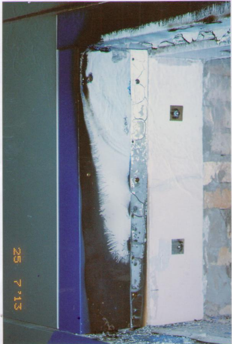
Рис. 5.8. Состояние после испытаний выполненной из «Alcotek FR Plus» накладной кассеты облицовки на боковом откосе оконного (огневого) проема образца фасадной системы.
